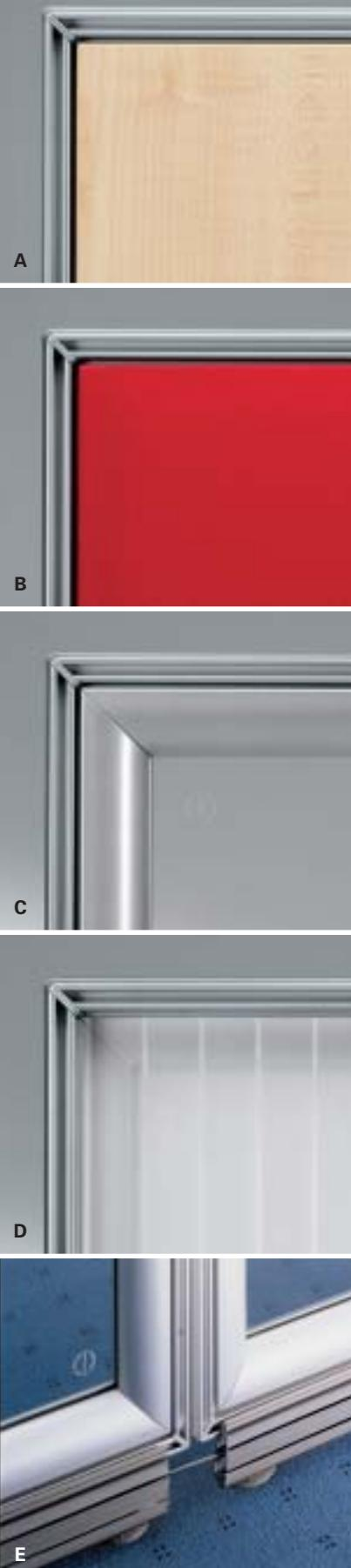
**(D)** A Dekorbeplankung. **B** Stoffbeplankung. **C** Klarglas. **D** Doppelstegplatte. **E** Kabelkanalprofil.
